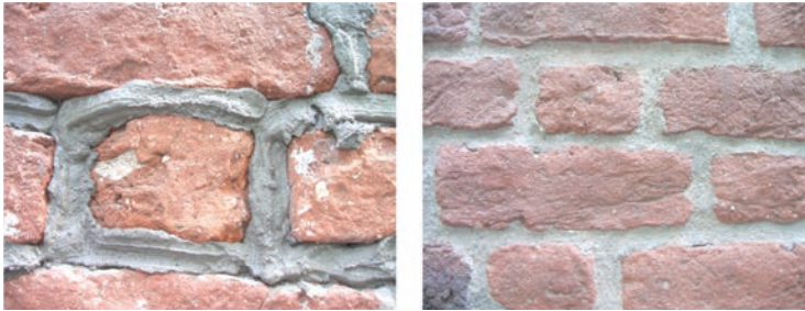
Fig. 14 – Fase di rifacimento delle malte di stilatura: malta applicata con fugatrice (a sinistra) e malta a lavorazione conclusa.
