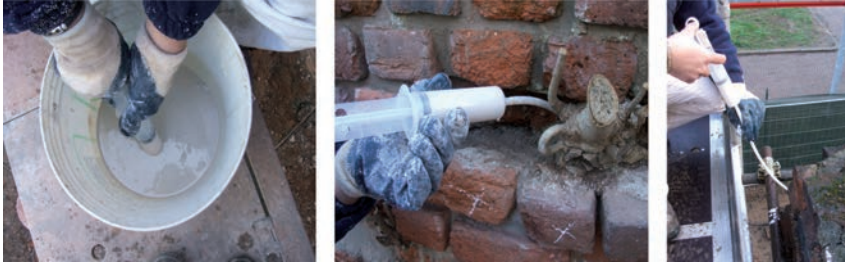
Fig. 15 – Sequenza fotografica della fase di consolidamento mediante iniezioni della muratura.
