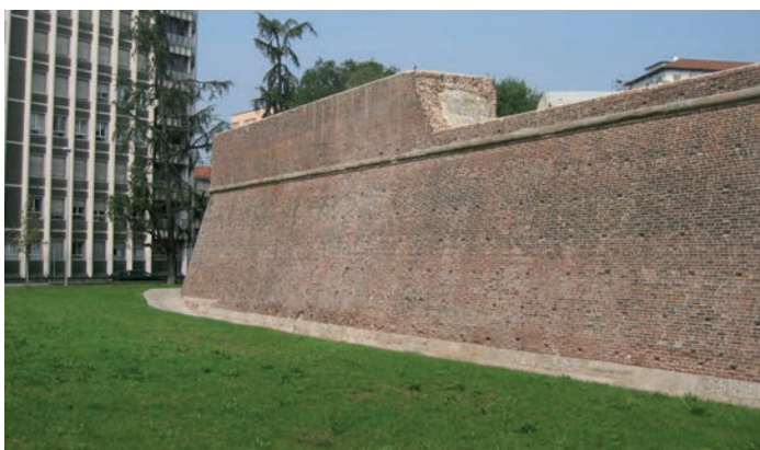
Fig. 19 – Fotografia del bastione al termine dei lavori (2009).
