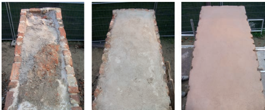
Fig. 18 – Sequenza fotografica dei vari strati della copertina sommitale posta sulle creste delle mura.
