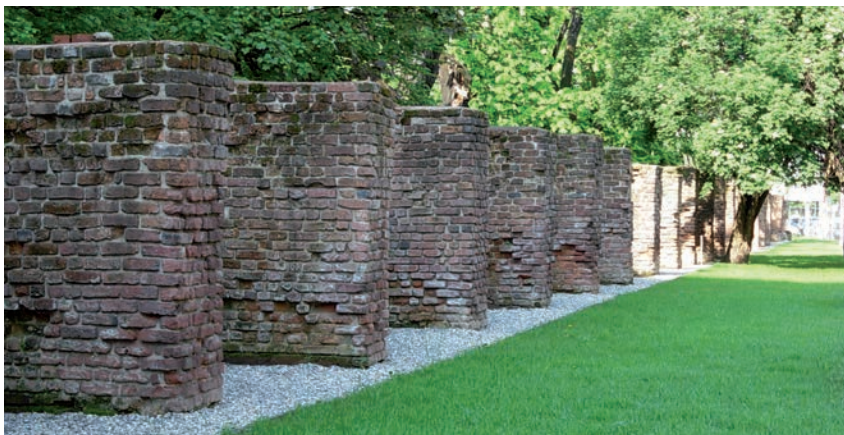
Fig. 20 – Fotografia del tratto T3 di viale Filippetti al termine dei lavori (2009).
