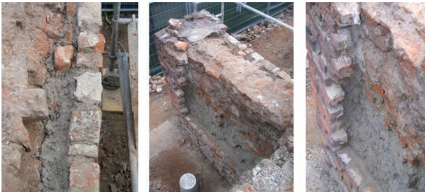
Fig. 16 – Dettagli fotografici della fase di consolidamento della muratura.
