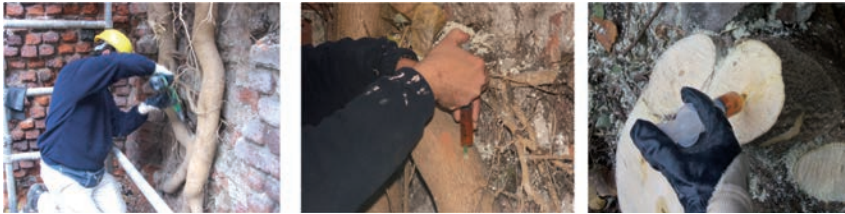
Fig. 11 – Sequenza fotografica del trattamento di “devitalizzazione” delle radici con le iniezioni di Picloram.
