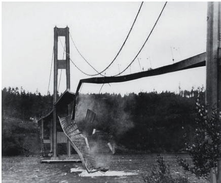
Fig. 10. Crollo del Tacoma.
